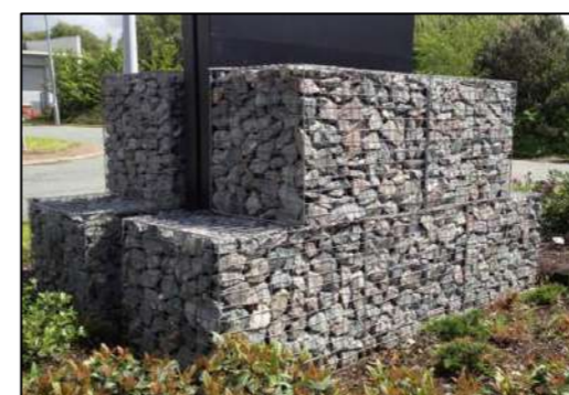
Figure 30 : Exemple de muret en gabion (Source : TCS Geotechnics)
