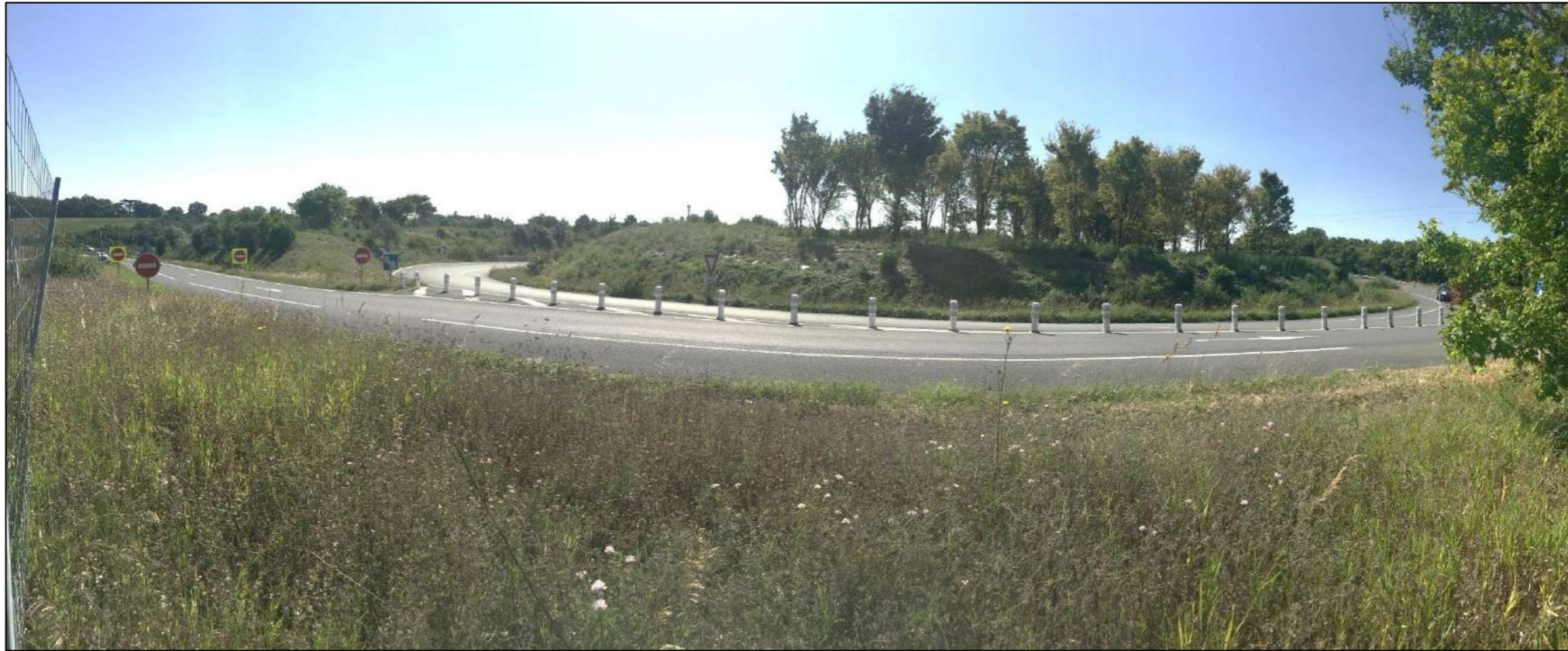
Vue 5' : Vue panoramique en direction du sud-est depuis la limite sud de la partie 1.
