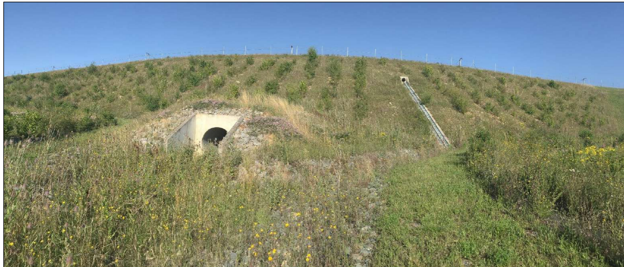
Vue 4' : Vue panoramique en direction de l'ouest depuis la limite ouest de la partie 1.
