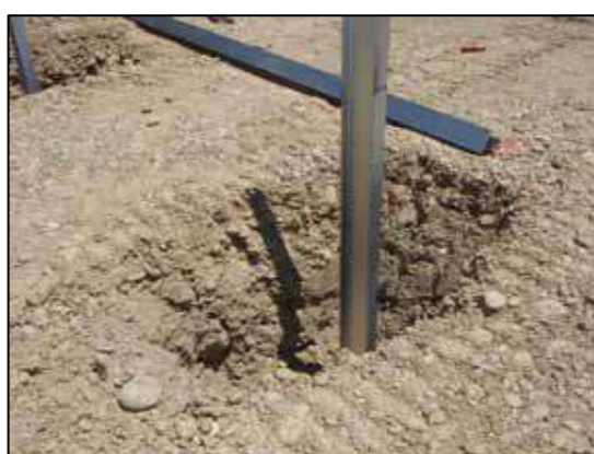
Figure 28 : Types de fondation - pieux battus (Source : Guide MEDDTL 2011 – NCA, 2015)
