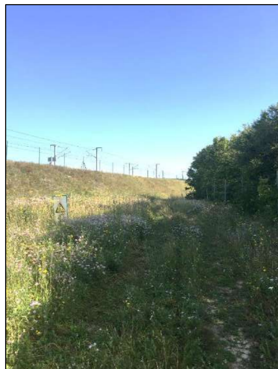
Vue A' : Vue en direction du nord depuis l'extrémité nord de la partie 2.
